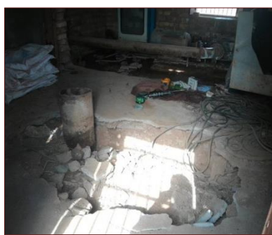
شکل ۱۹. شواهد لوله‌زایی در چاه‌های تأمین آب شرب شهری (چاه شماره ۱۰ شهر کوهدشت با عمق ۶۰ متر) و چاه کشاورزی واقع در غربی و مرکزی دشت
