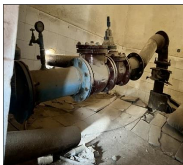
شکل ۱۹. شواهد لوله‌زایی در چاه‌های تأمین آب شرب شهری (چاه شماره ۱۰ شهر کوهدشت با عمق ۶۰ متر) و چاه کشاورزی واقع در غربی و مرکزی دشت
