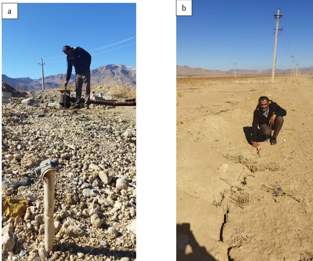
شکل ۵. ترک‌های کششی زمین و کج شدن تیر چراغ‌برق‌ها در منطقه جنوب غربی سفیددشت، زمین‌های بنیاد؛ (b) لوله زایی در منطقه جنوبی دشت، سه‌راهی دهنو
