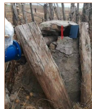
شکل ۱۹. شواهد لوله‌زایی در چاه‌های تأمین آب شرب شهری (چاه شماره ۱۰ شهر کوهدشت با عمق ۶۰ متر) و چاه کشاورزی واقع در غربی و مرکزی دشت
