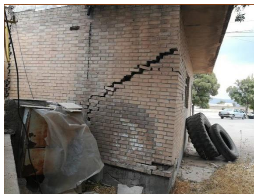
شکل ۲۰. نشست پایه و گسیختگی ساختمان ورودی اداره راهداری و حمل‌ونقل جاده‌ای شهر کوهدشت
