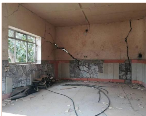
شکل ۲۰. نشست پایه و گسیختگی ساختمان ورودی اداره راهداری و حمل‌ونقل جاده‌ای شهر کوهدشت
