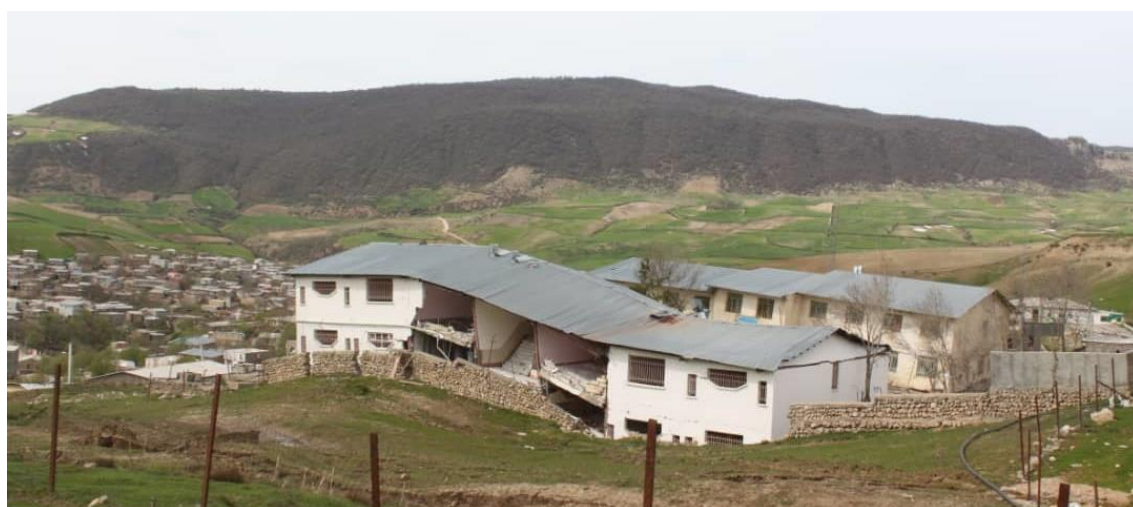
تخریب مدرسه شبانه‌روزی هاجر در روستای حسین‌آباد
